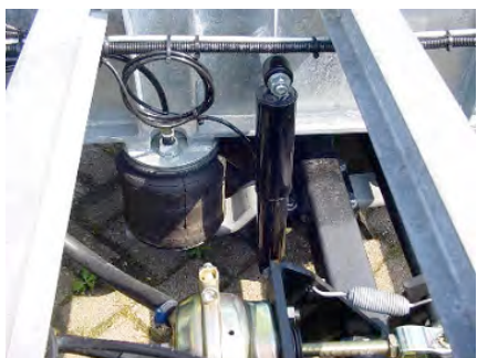
Leidingen en bedrading schuur en trillingsvrij gemonteerd.
