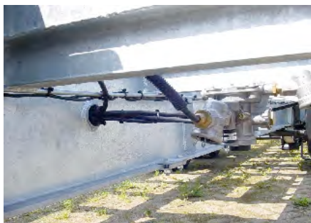
Luchtleidingen op kritieke punten voorzien van mantelbuis.
